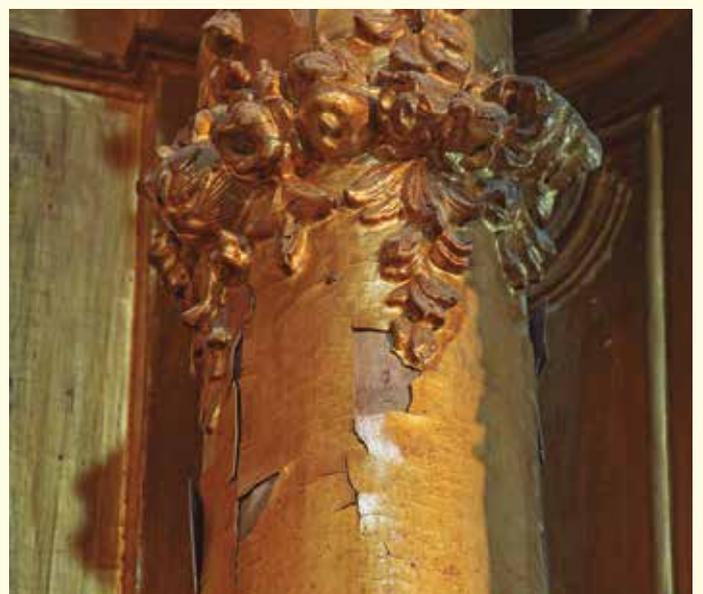
Debido al sistema constructivo empleado, la ménsula que soporta la hornacina central, se ha deformado. Esta zona, presenta una acumulación de tensiones constructivas provenientes del peso que soporta, así como del peso de las personas que se suben para manipular la Virgen de los Dolores.
